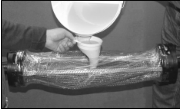
FIGURE 8 - POUR ENCAPSULANT INTO LINER
